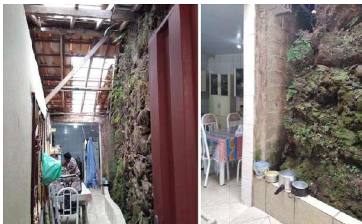
Imagem 3 e 4: Cozinha da residência, ambiente em que parte do mundéu está exposto, sendo uma das paredes estruturais.
