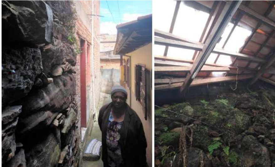
Imagem 5: Moradora apresentando as estruturas dos mundéus Imagem 6: Madeiramento do telhado integrado ao muro
